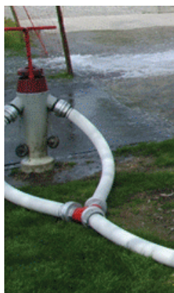
Abb. 4.2: Überflurhydrant und Standrohr am Unterflurhydranten
