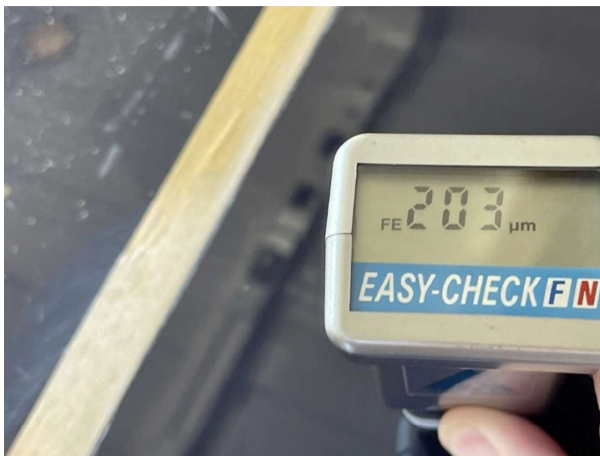
Abbildung A5.2 – Messung Lackdicke Detail
