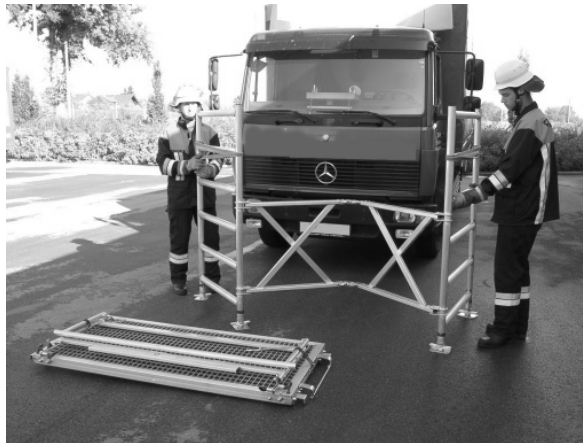
Rahmen aufklappen bis beide Scharniere am Klapprahmen einrasten.
