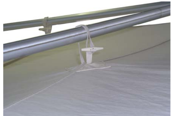
Detail 4: Einhängen in der Dachfläche
