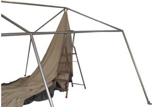
Bild 1: Begonnen wird am Hintergiebel am First.
