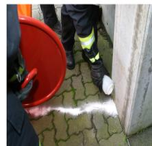
Fugen, Ritze, Bordsteinkanten Schienen und Mauerecken können mit Erde oder Dichtquell abgedichtet werden
