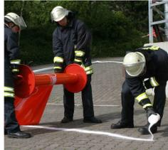
An Bordsteinkanten, Mauern und Vertiefungen einen Schlauchüberschuss abrollen, so das sich der Schlauch an die Unebenheiten anlegen bzw. hinein drücken kann. Schlauch ggf. legen.
