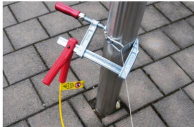
Erdung am Mast mit Hilfe einer Schraubzwinge
