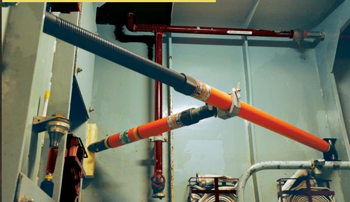
H-Abstützung kann horizontal wie vertikal genutzt werden. Es werden moderate Lastaufnahmen erzielt.
