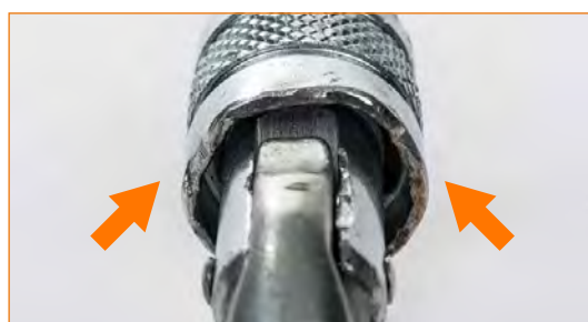
Verbindungselement mit äußerst beschädigtem Schraubverschluss.
